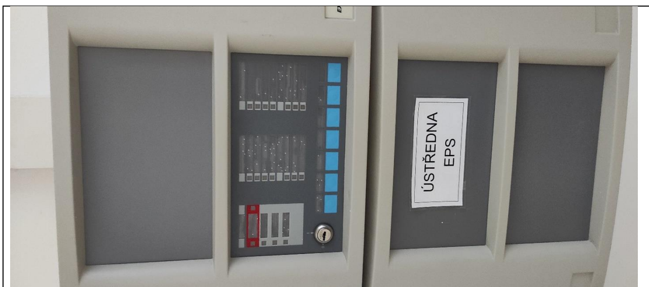
Pohled na stávající ústřednu EPS v rozvodně
